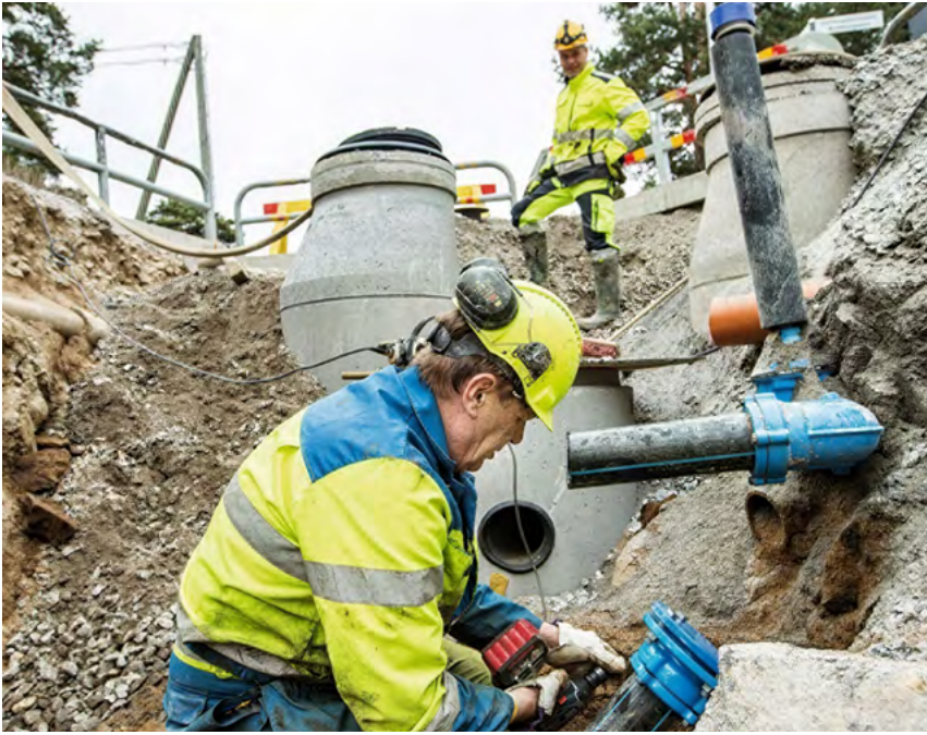
Verkoston asentamista Turun Vesihuollon työmaalla.
